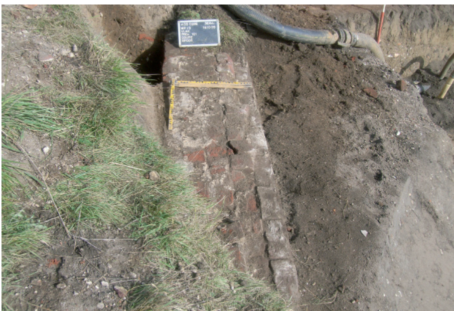
Afb. 5.25 Muur S27. Foto genomen richting het noordoosten.
