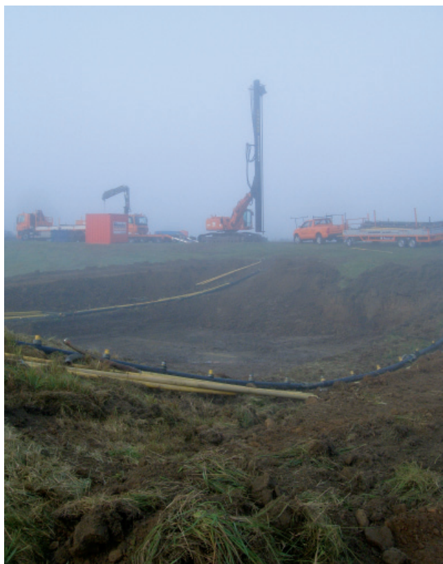
Afb. 4.2 Het plaatsen van de bronbemaling vereiste een flinke inzet van mensen en materiaal. Foto genomen richting westen, ten noorden van proefsleuf 8.
