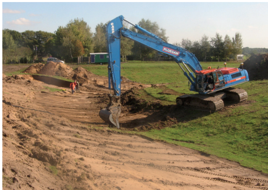
Afb. 4.5 Verwijderen van de bouwvoor voor aanvang van de werkzaamheden op het kroonwerk.
