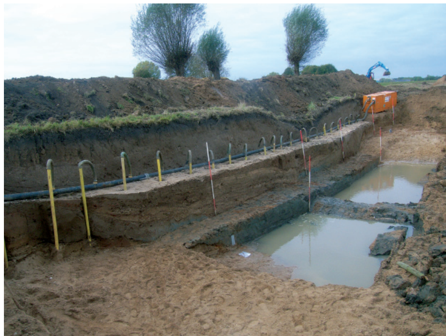
Afb. 5.13 Profiel proefsleuf 11. Foto genomen richting het westen.
