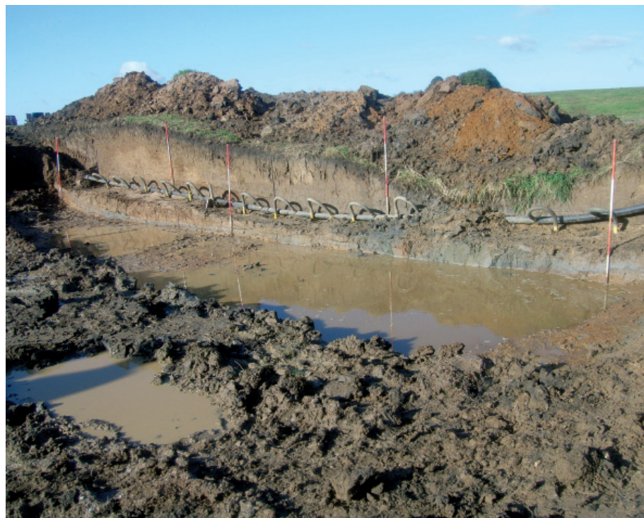
Afb. 5.11 Profiel proefsleuf 9. Foto genomen richting het zuidwesten.
