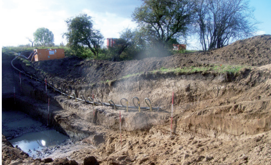
Afb. 5.15 Profiel proefsleuf 12. Foto genomen richting het westen.
