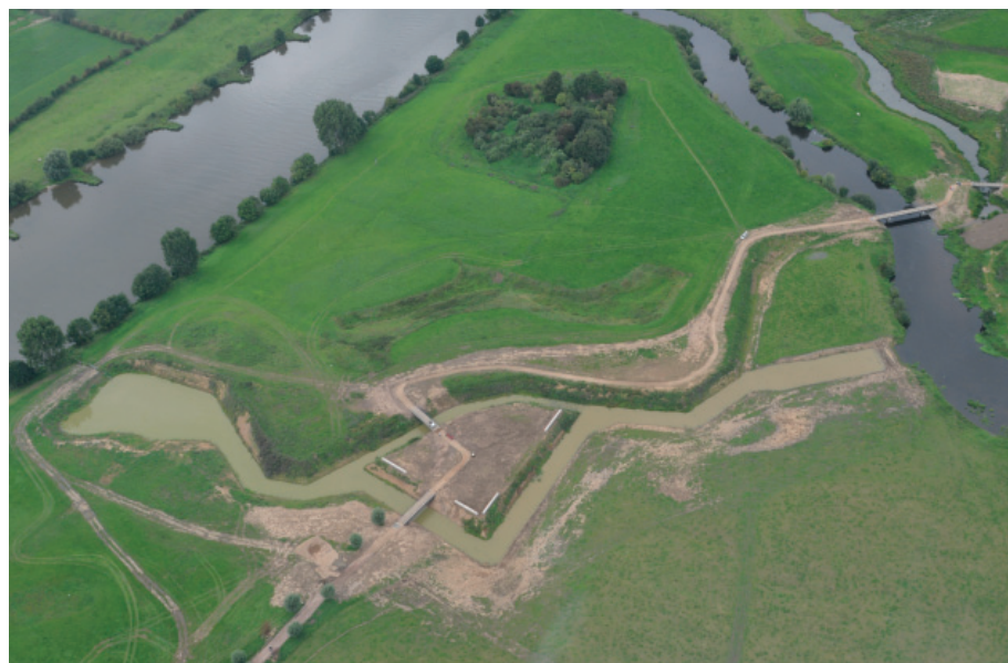
Afb. 7.1 Luchtfoto van het plangebied na afloop van de werkzaamheden. Foto genomen richting het westen door H. Jaspers uit Gennepe.
