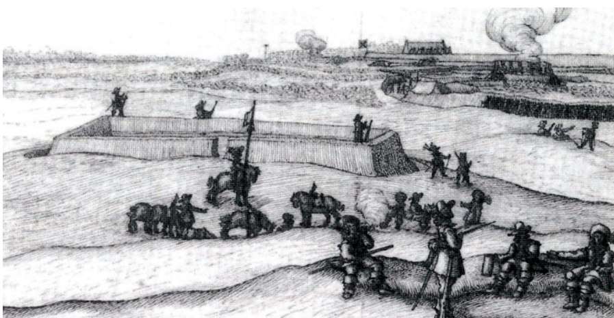
Afb. 2.22 Gezicht op de westelijke aanvallinie vanuit Middelaar. Op de voorgrond links een aarden redoute, in het midden een approche (loopgraaf) met daarin meerdere manschappen en rechts een batterij met kruitdampen. Detail uit een gravure door Jacob van Geelkercken uit 1641. Rijksarchief in Gelderland, Arnhem. Collectie AKV 779, kaart 618.
